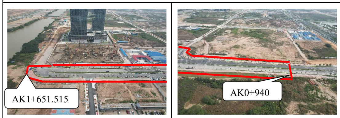
道路工程区 A 段 (AK0+940~ AK1+651.515) 现状
